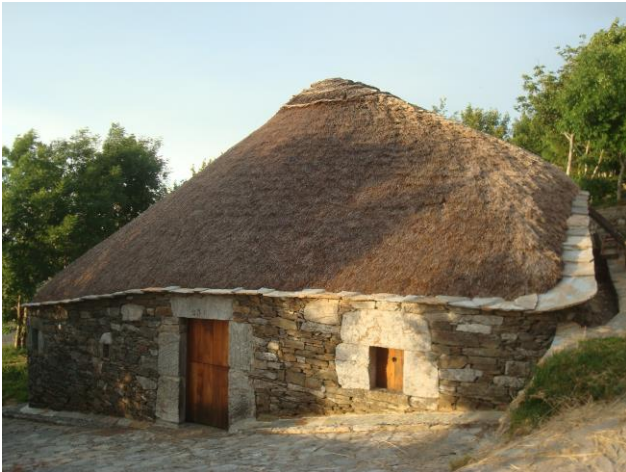
Maison avec toit de chaume à O Cebrero
